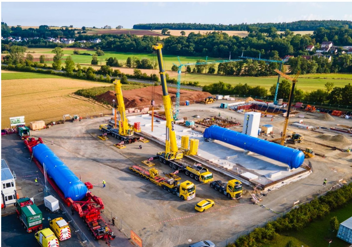
Tankanlieferung auf dem REEFUELERY Gelände in Burghaun © REEFUELERY GmbH x Robert Gross
