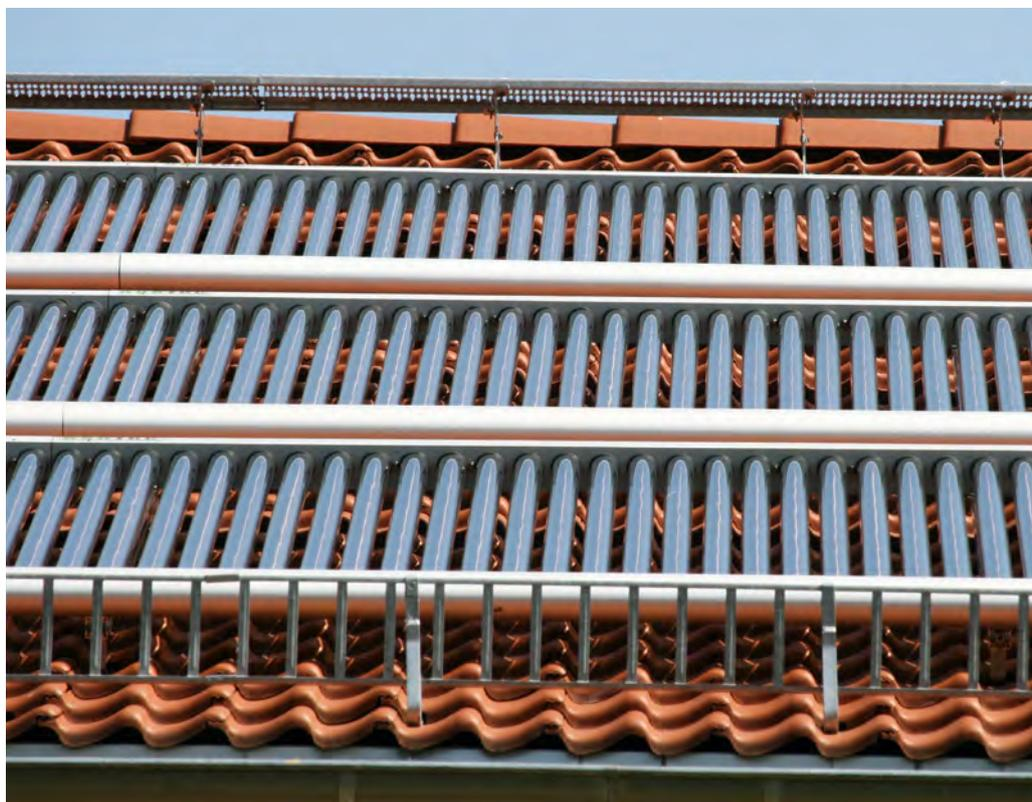
Eine Solarthermieanlage ist das wohl erprobteste Mittel für die nachhaltige Ausgestaltung einer Heizungsanlage.
