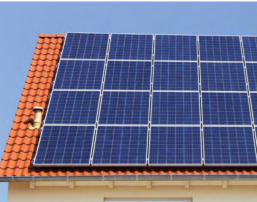
Photovoltaik lässt sich bei einer umfassenden energetischen Sanierung gut installieren und bei Überschuss in den Pufferspeicher einbinden.
