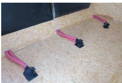
Die Ansaugsonden sind gleichmäßig auf dem Boden des Pelletlagers verteilt.
