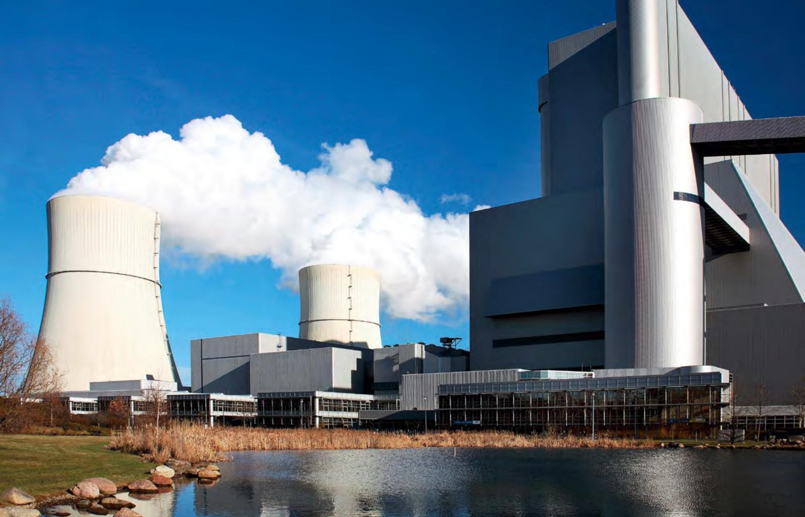
Das LEAG-Kraftwerk Schwarze Pumpe besteht aus zwei Kraftwerksblöcken mit einer Leistung von je 800 MW.
